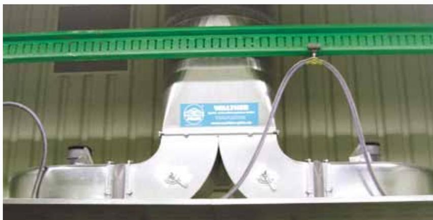
Zwei Ventilatoren (links: Flügelrad linksdrehend, rechts: Flügelrad rechtsdrehend). Die Abluft wird in einer Rohrleitung zusammengefasst.
