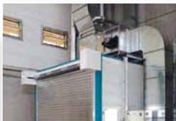
Lackierkabine mit platzsparender Anordnung des Aggregats auf dem Dach
