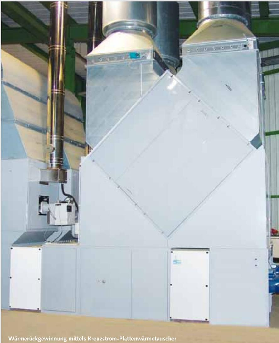
Wärmerückgewinnung mittels Kreuzstrom-Plattenwärmetauscher
