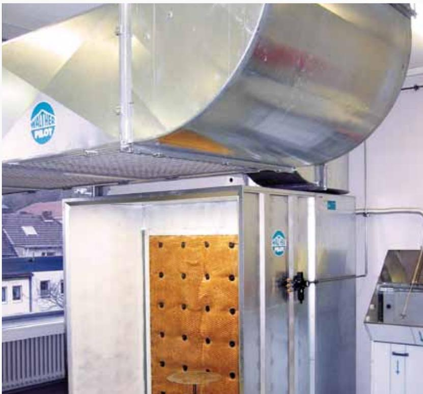
Bei der Farbnebelabsaugung fallen erhebliche Abluftmengen an. Daher müssen entsprechende Luftmengen zugeführt und je nach Außentemperatur beheizt werden.
