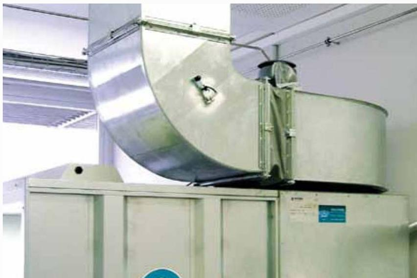
Ventilator (Flügelrad rechtsdrehend) mit Manschette für den problemlosen Anschluss an die Abluft-Rohrleitung
